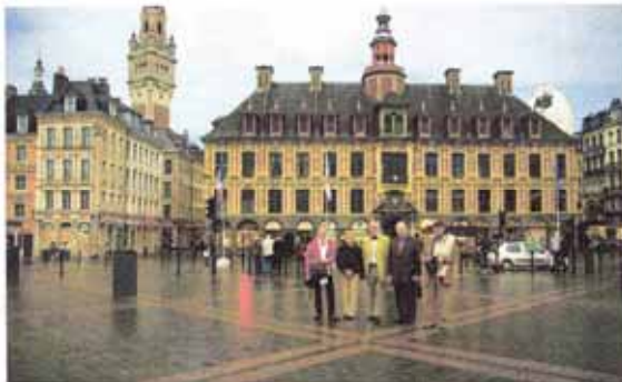
La Vieille bourse construite en 1653, au fond le beffroi de la Nouvelle bourse
