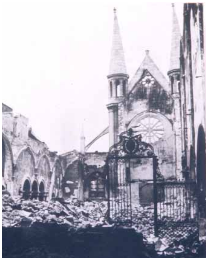
Fig. 3 - L'église Saint-Paul après le bombardement et l'incendie.
