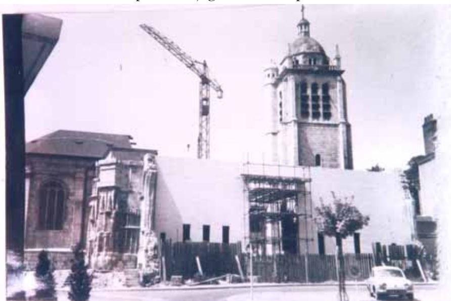
Fig. 6 - L'édification du nouveau sanctuaire est en cours.
