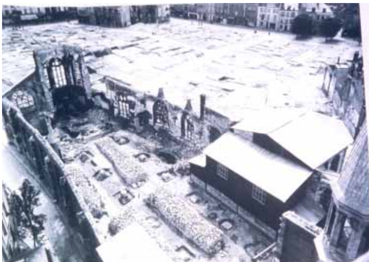
Fig. 4 - L'église sinistrée : vue générale.
