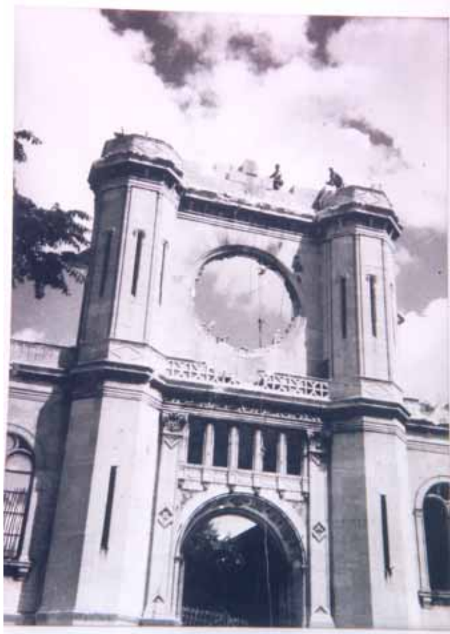
Fig. 5 - Les clochetons sont démolis.
