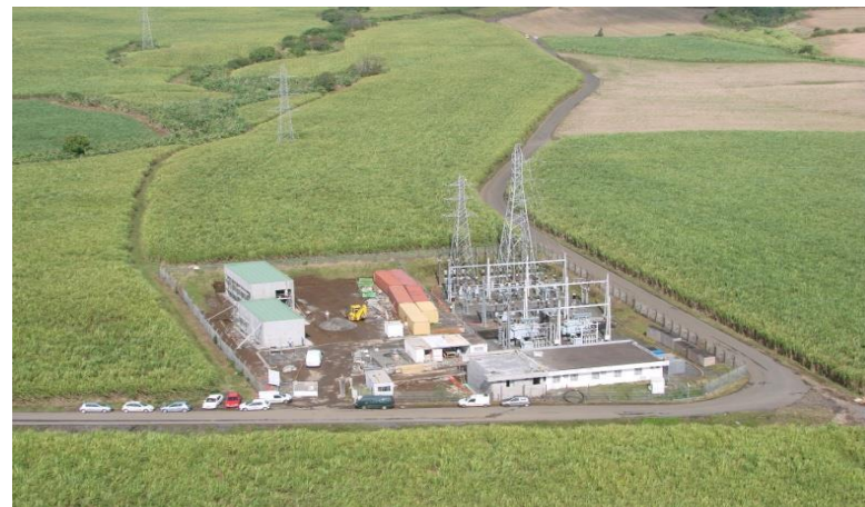
Batterie NaS 1MW – 7,2 MWh. Poste source 63kV/15kV de Saint André. EDF SEI La Réunion.
